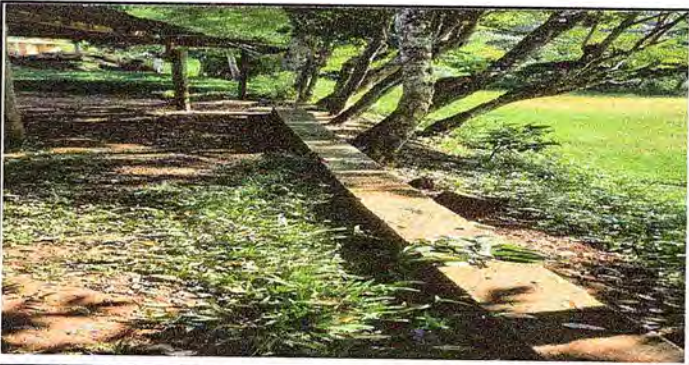
Foto 5: Se observa la falta de block de piedra en esta parte del modulo de la circulacion.
