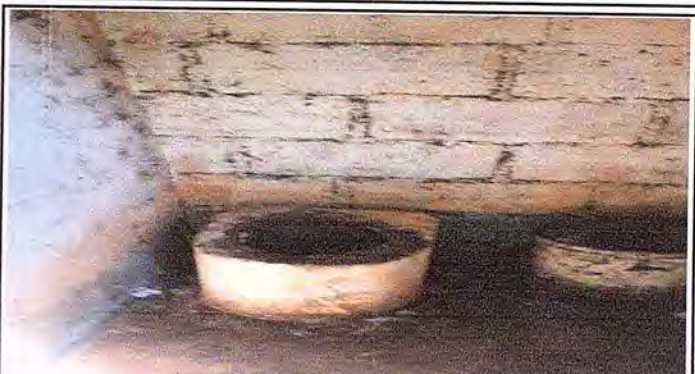
Foto 2: Se observa el deterioro de la taza sanitaria del modulo de la letrina.
