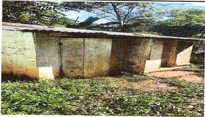
Foto1: Se observa el deterioro de la estructura de la pared del modulo de la letrina.
