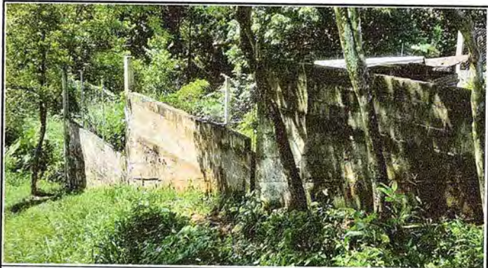
Foto 4: Se observa la falta de mallas en esta parte del modulo de la circulacion de la escuela.
